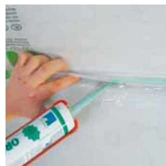
Raccord du freine-vapeur à une cheminée enduite avec pro clima ORCON F.
